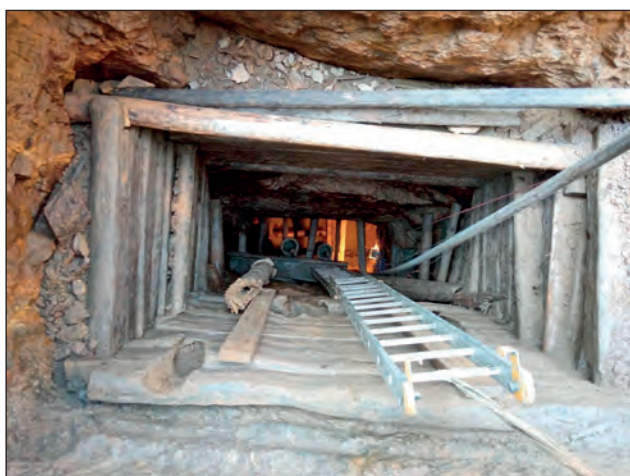
Obr. 4. Vyčerpaný prostor šachty. Fig. 4. Dewatered shaft space.
