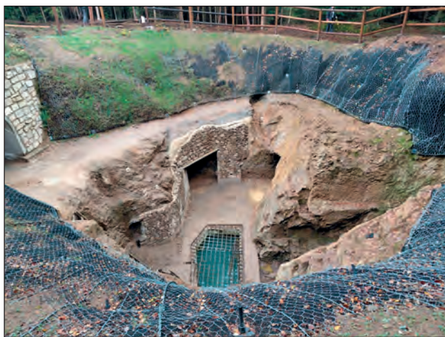
Obr. 6. Dokončení zajišťovacích prací. Fig. 6. Completion of security measures.
