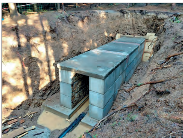
Obr. 5. Prodloužení odvodňovací štoly. Fig. 5. Extension of water drainage adit.
