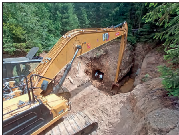
Obr. 3. Odtěžování zásypu šachty. Fig. 3. Removal of the shaft backfill.
