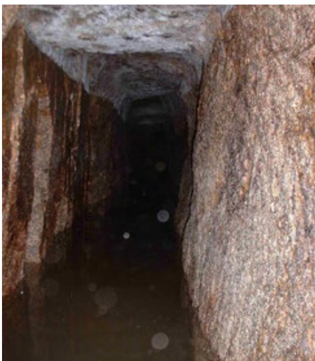
Obr. 4. Štola faráře Plössela – interiér překopu v hluchých partiích masivu; patrně rozšíření přirozené dislokace masivu (Foto Petr Bouše).
