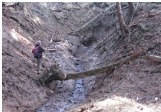
Obr. 2. Zasuté ústí štoly Jan, patrně odvodňovací štoly revíru (Foto autor).
