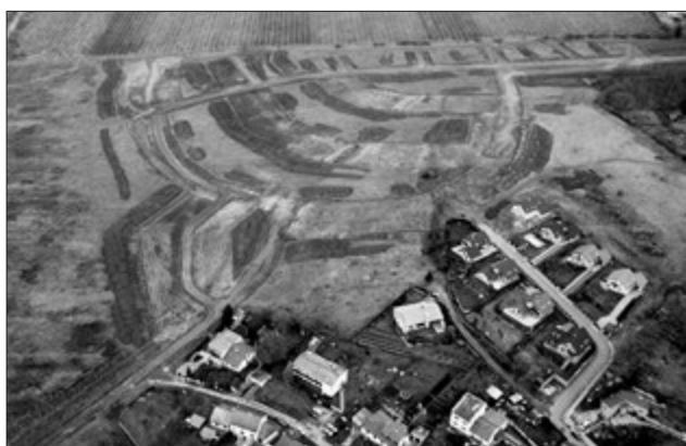
Obr. 4. Šikmý letecký snímek lokality u „Všech svatých“ s dobře patrným rozsahem realizovaných skrývek. Foto autor.
