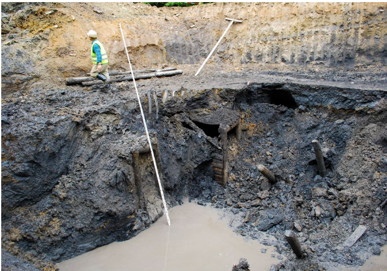
Obr. 4. Štoly odkryté stavební jámou.
