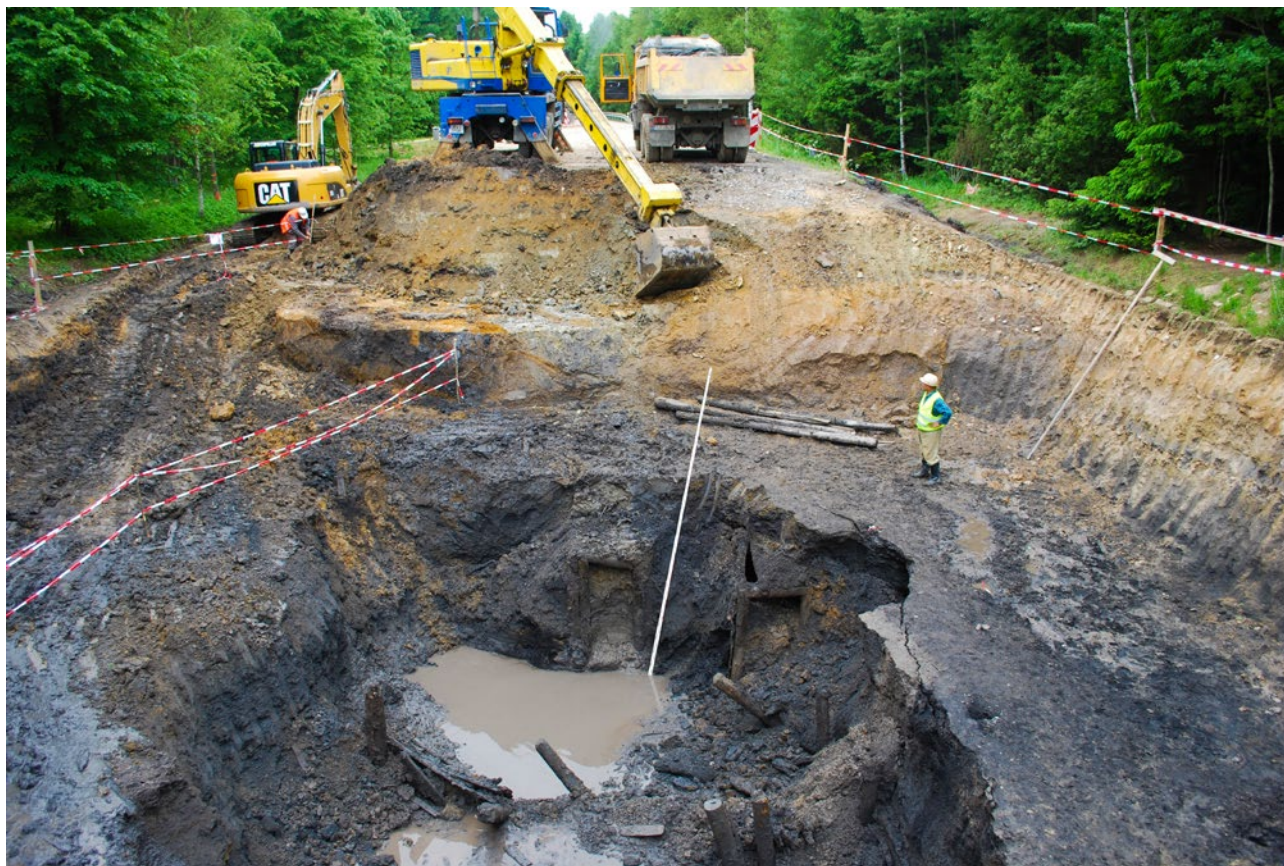
Obr. 3. Celkový pohled na lokalitu – stavební jáma v místě propadu silnice.
