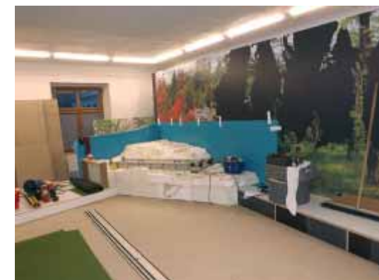
Budování přírodovědných expozic
